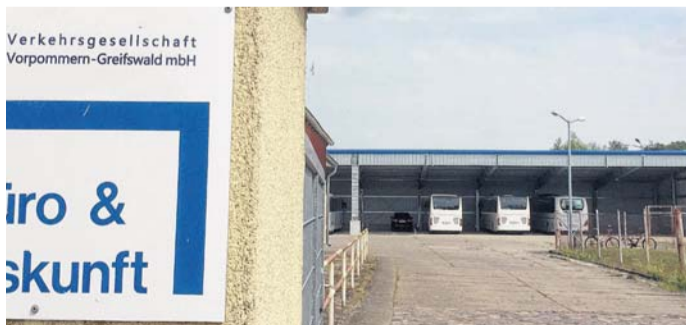
Auf dem Betriebshof in der Demminer Straße in Jarmen entsteht im hinteren Bereich eine neue Unterstellhalle. FOTO: ULRIKE ROSENSTÄDT
