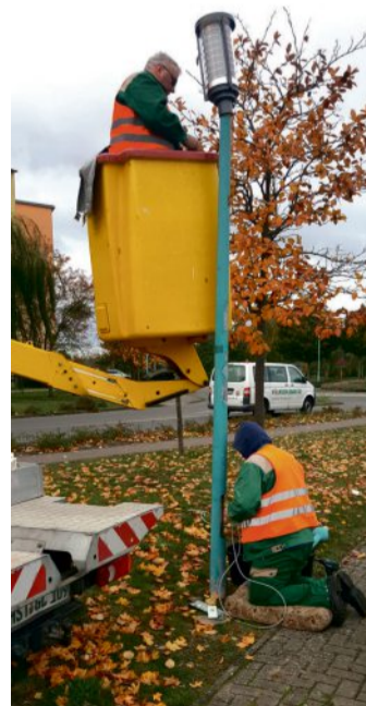
Die Umrüstung der Straßenbeleuchtung in Ueckermünde auf LED-Lampentechnik geht weiter. FOTO: ZVG
